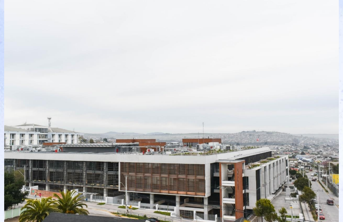
Imagen real, Etapa de ejecución
